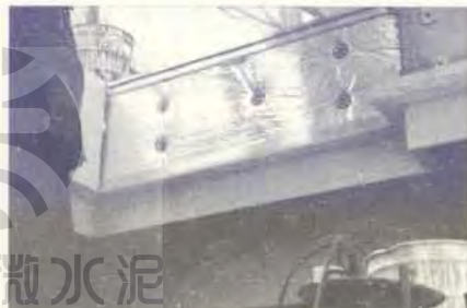
图9 将玻璃棉保温层用尼龙胀栓固定
