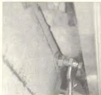
图11 调整可调性定位部件 (固定系统)
