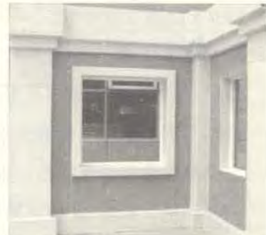
图12 系统安装完成
