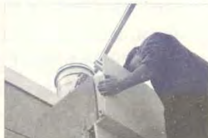
图10 将板边插入龙骨卡槽
